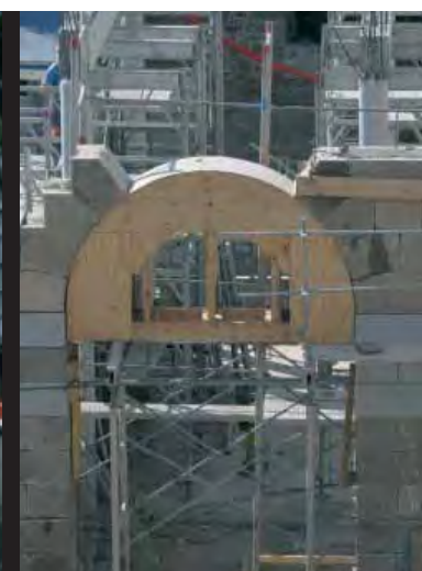
Restauration du bâtiment ancien "Nous n'avons conservé que les murs."
