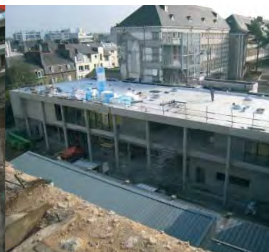
Construction du bâtiment neuf (espace restauration et salles scientifiques) "L'ancien réfectoire, toujours en fonction, et l'aile du bâtiment étaient à quelques centimètres du bâti en construction. Un travail de précision pour tous les compagnons!"
